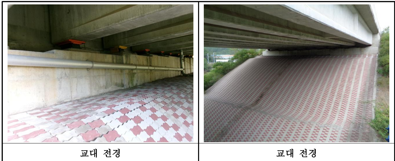
【사진 38.3.33】 교대 전경
