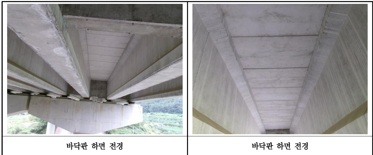
【사진 38.3.27】 바닥판하면 전경
