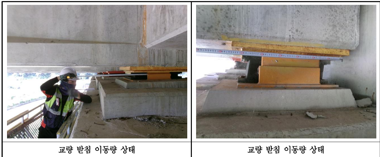
【사진 38.3.15】 교량받침 이동량 상태
