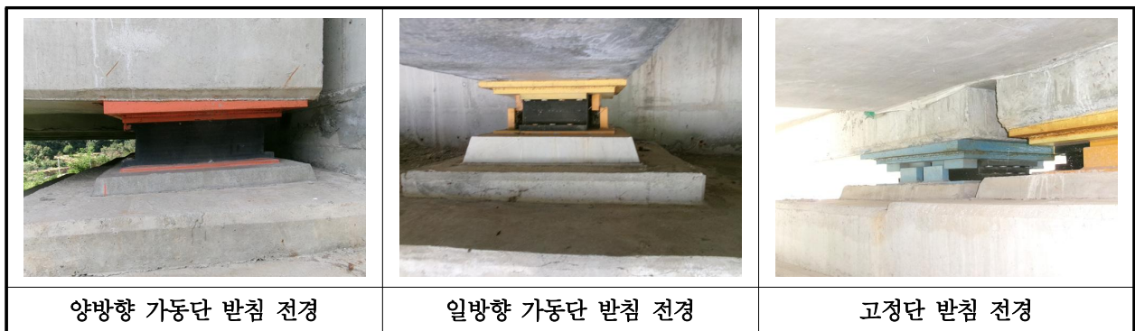
【사진 38.3.12】 교량받침 전경
