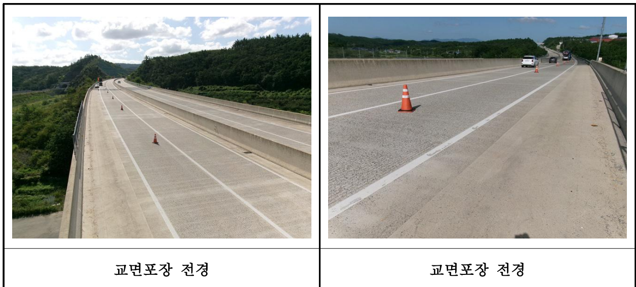
【사진 38.3.19】 교면포장 전경
