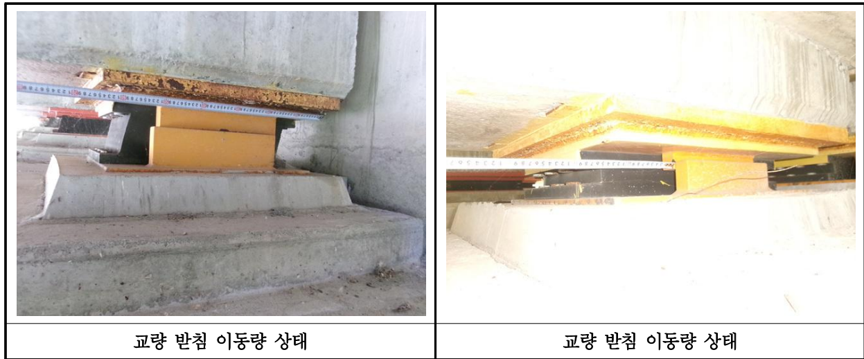
【사진 38.3.40】 교량받침 이동량 상태
