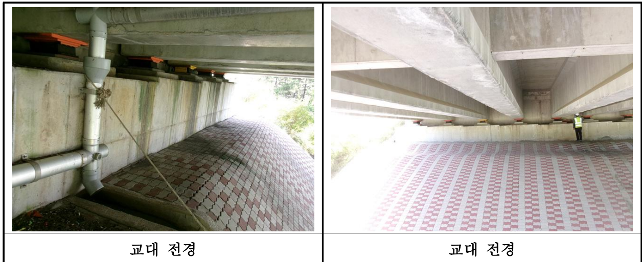
【사진 38.3.8】 교대 전경
