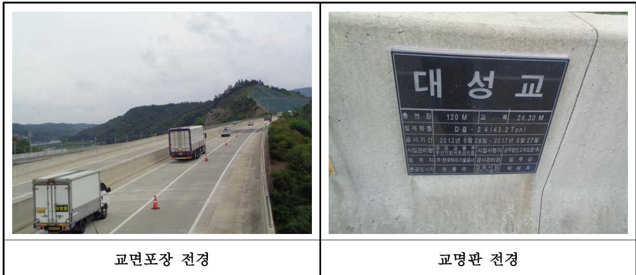
【사진 38.3.44】 교면포장 전경
