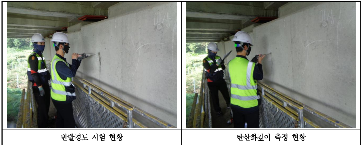
【사진 38.4.1】 콘크리트 내구성조사 현황
