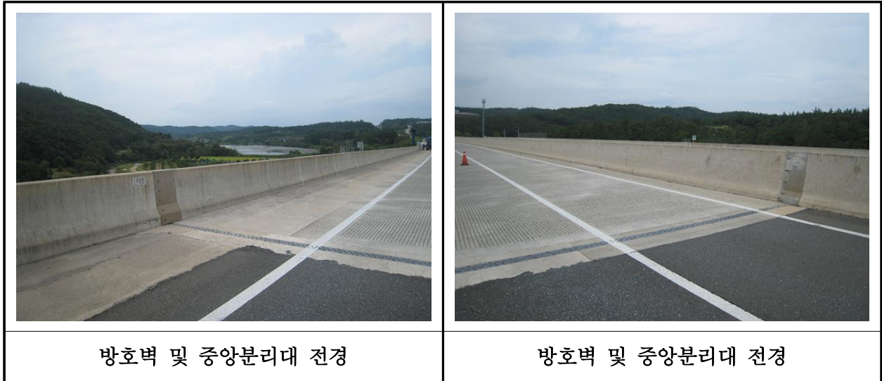
【사진 38.3.48】 방호벽 및 중앙분리대 전경
