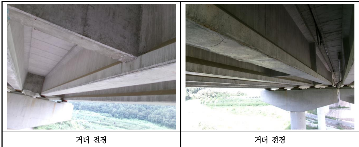
【사진 38.3.29】 거더 전경
