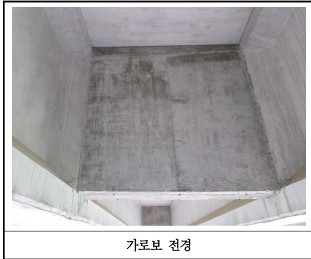
【사진 38.3.31】 가로보 전경
