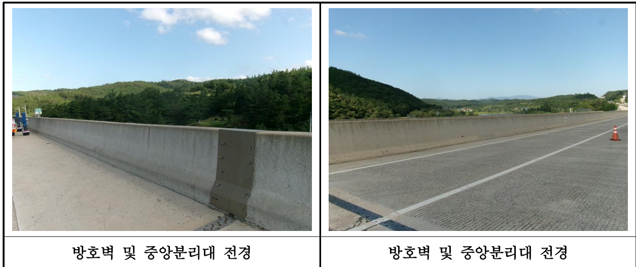
【사진 38.3.23】 방호벽 및 중앙분리대 전경
