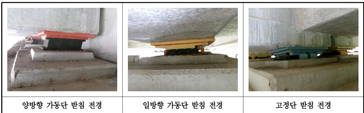
【사진 38.3.37】 교량받침 전경
